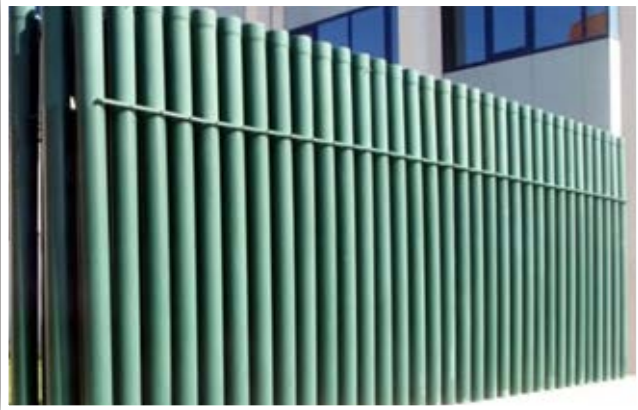
Figura 2. Primer prototipo de pantallas acústicas basadas en cristales de sonido de primera generación, situado en el campus de la Universitat Politècnica de València.
