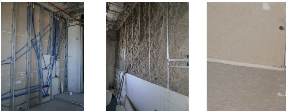
Figura 1. A modo de ejemplo se aprecian tres aspectos vinculados al control de obra en la ejecución de un tabique liviano: instalaciones interiores, relleno de celulosa proyectada y sellado perimetral de juntas.
