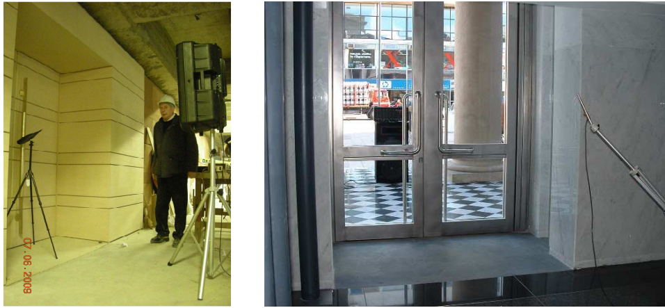
Figura 2. A la izquierda, se aprecia el proceso de medición del aislamiento de una puerta de acceso a la sala Eduardo Fabini del Auditorio Adela Reta. La misma se construyó a los efectos de ser evaluada acústicamente como muestra. A la derecha, la medición final de Al aislamiento de una puerta de acceso al teatro Solís.
