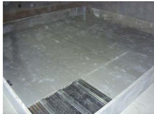
Figura 6 – Colocação da lã mineral de 70 kg/m<sup>3</sup> e 100 mm
