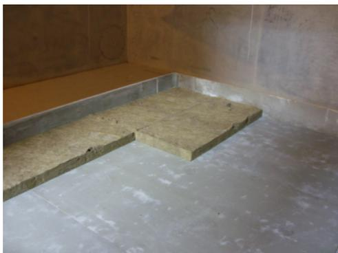
Figura 7 – Colocação segunda placa de aglomerado madeira e cimento e Lã mineral 40 kg/m<sup>3</sup> e 200 mm de espessura
