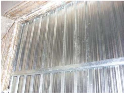
Figura 11 – Montagem da chapa trapezoidal na gola entre as câmaras R1 e E1 (emissor)
