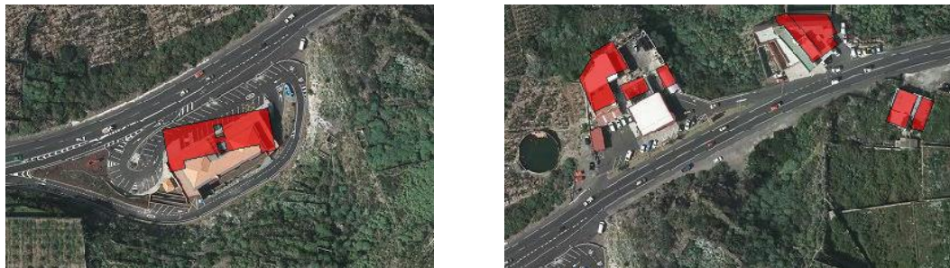
Fig. 7 – Edificios desplazado (izquierda) y edificios girados (derecha)
