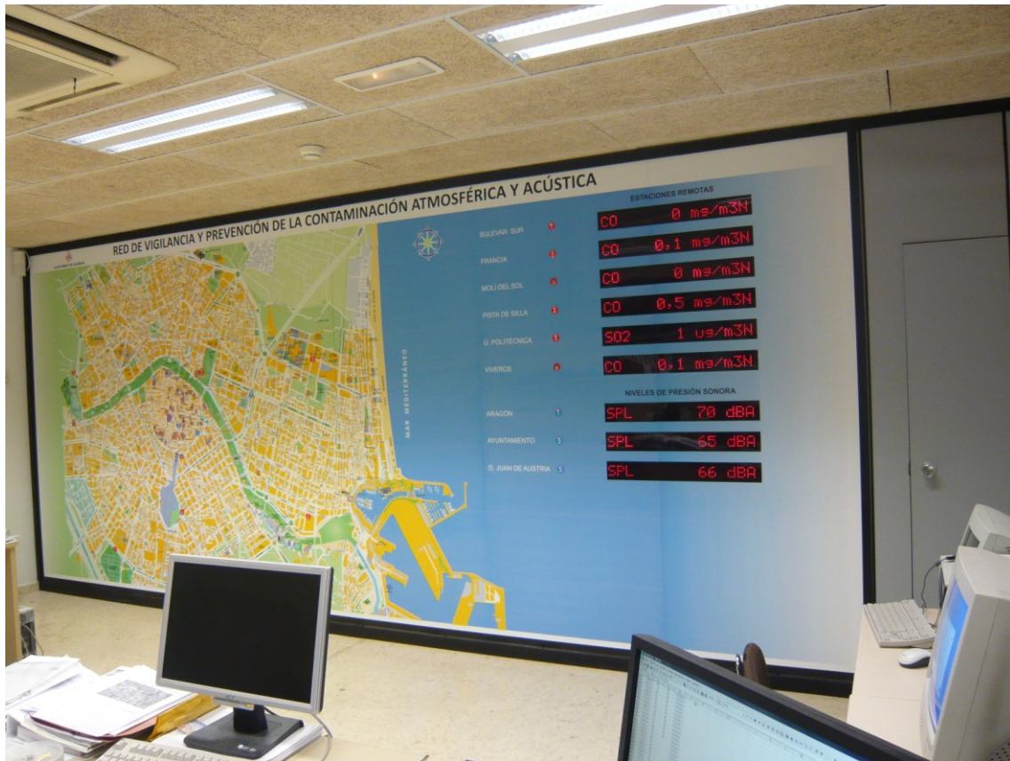
Estación Central de Control del Ayuntamiento de Valencia
