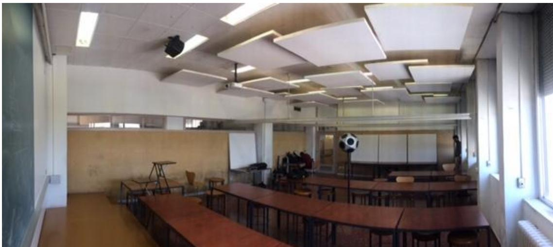
Figura 2. Fotografía aula A 6.2. E.T.S.A.B. con instalación de placas fonoabsorbentes.
