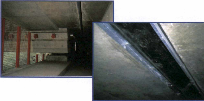
Figura 7.15. Obturación acústica tipo lámina de caucho de una junta de dilatación
