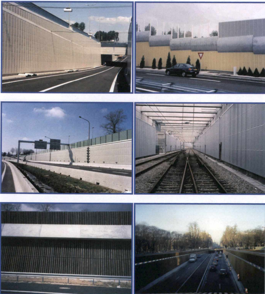
Figura 7.12. Ejemplos de revestimientos absorbentes realizados con módulos metálicos y de madera
