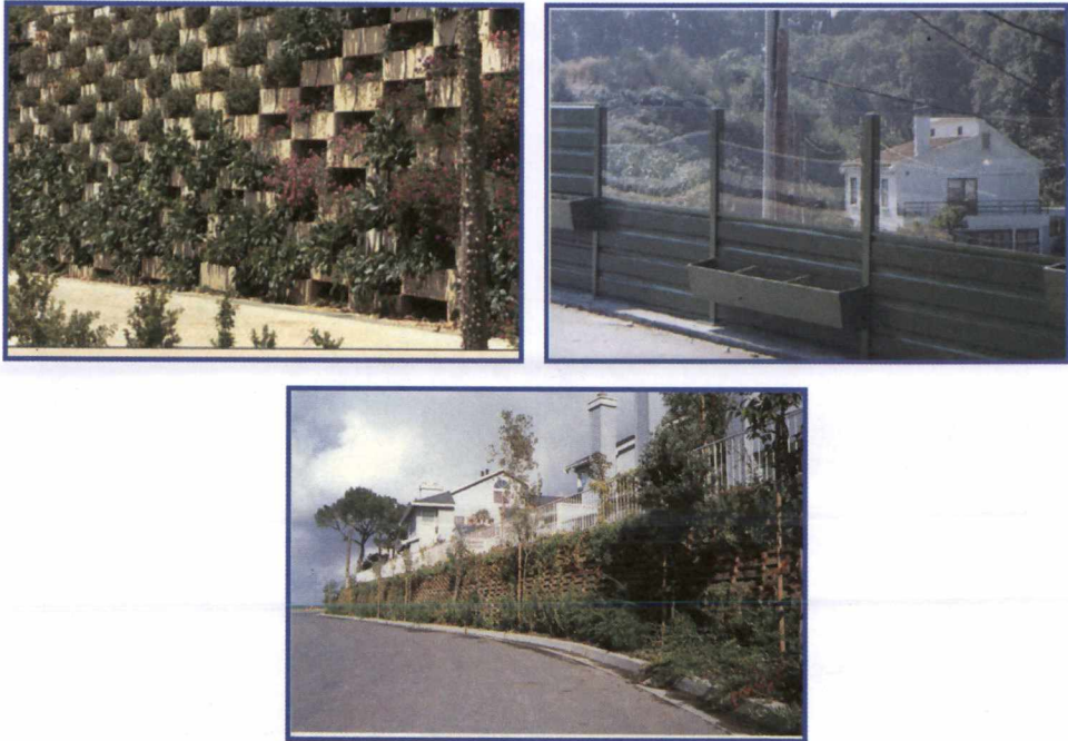
Figura 7.11. Ejemplos de pantallas tipo jardinera
