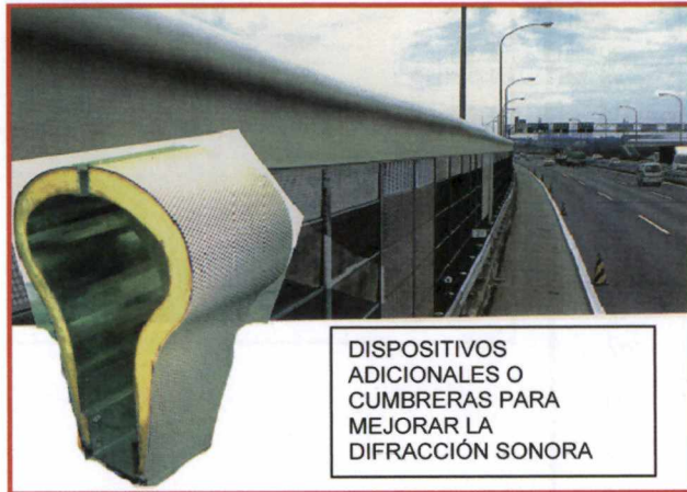
Figura 7.18. Ejemplo de dispositivos reductores de ruido objeto de TS 1793-4
