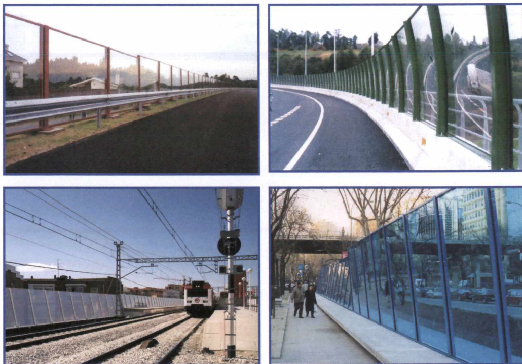
Figura 7.7. Ejemplos de pantallas realizadas con módulos transparentes
