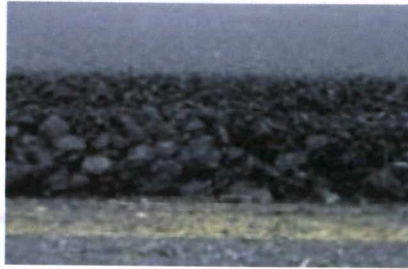
Figura 8.19. Imagen de un Asfalto Poroso de doble capa
