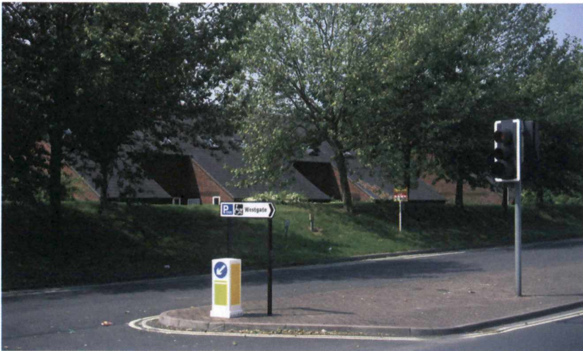
Figura 5.14. Ejemplo de arquitectura defensiva: desmaterialización de la fachada ruidosa e integración en la medida de apantallamiento. Viviendas junto al cinturón urbano de Oxford, Inglaterra
