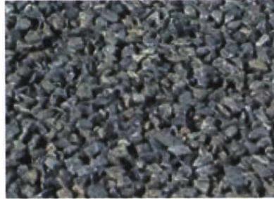
Figura 8.18. Imagen de un asfalto poroso
