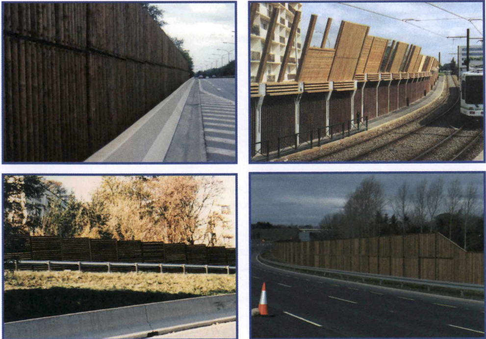
Figura 7.10. Ejemplos de pantallas realizadas con módulos de madera
