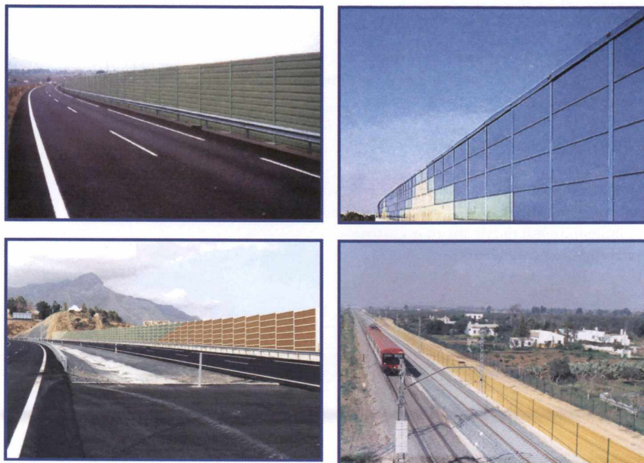
Figura 7.9. Ejemplos de pantallas realizadas con módulos metálicos tipo “sandwich”
