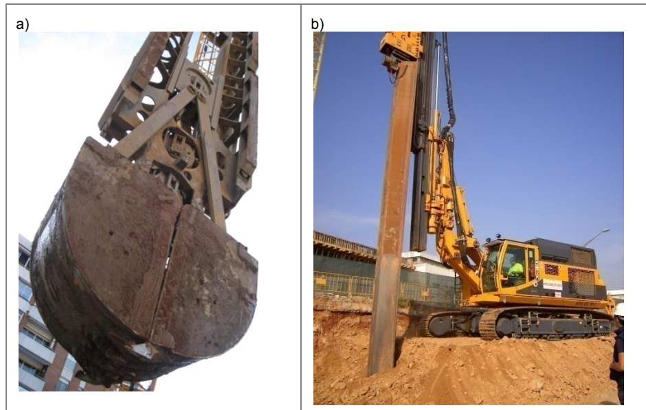
Figura 2.1. a) Vista de una cuchara bivalva para la ejecución de un muro pantalla y b) vista del proceso de hincado de una tablestaca.
