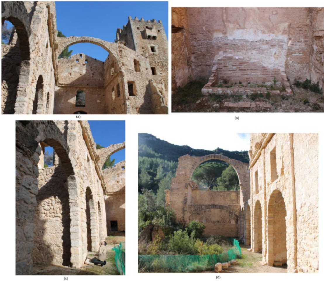
Figura 2. Fotografías del estado actual de la iglesia del monasterio: (a) Parte anterior de la iglesia con vista de arco y Torre de las Palomas. (b) Parte de una capilla lateral (se ve altar roto, algunas losetas en el suelo y partes de yeso sobre la pared). (c) Midiendo la altura de los arcos. (d) Vista de la parte posterior de la iglesia (vista similar a la de la Figura 1b)
