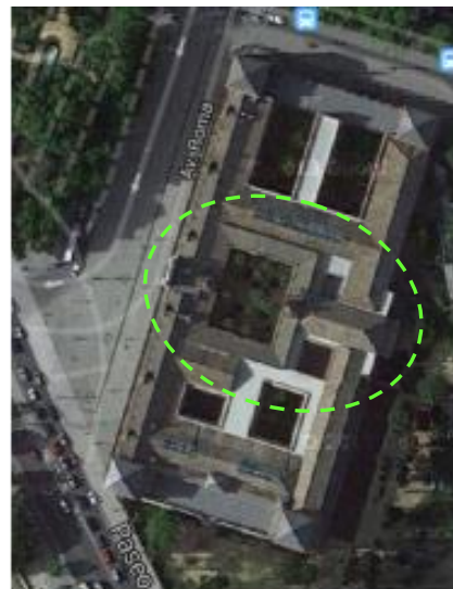
Figura 1. Vista general del Palacio de San Telmo. Eje central portada-capilla.
