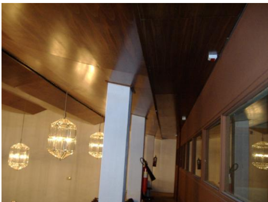
Figura 3.- Paneles curvos del techo. Detalle.
