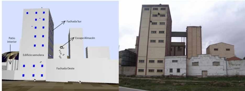
Figura 2. Comparación entre la visión 3D del modelo y realidad. Fachada oeste.
