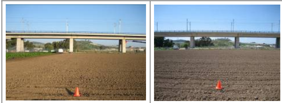
Figura 4.1. Vista de la disposición de los acelerómetros utilizada para la caracterización de la propagación de vibraciones en el terreno generadas por la circulación ferroviaria sobre viaducto.
