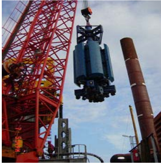
Figura 12. Infraestructura de perforado de fondo para instalación de pilotes soporte de aerogeneradores en un Parque Eólico Offshore.
