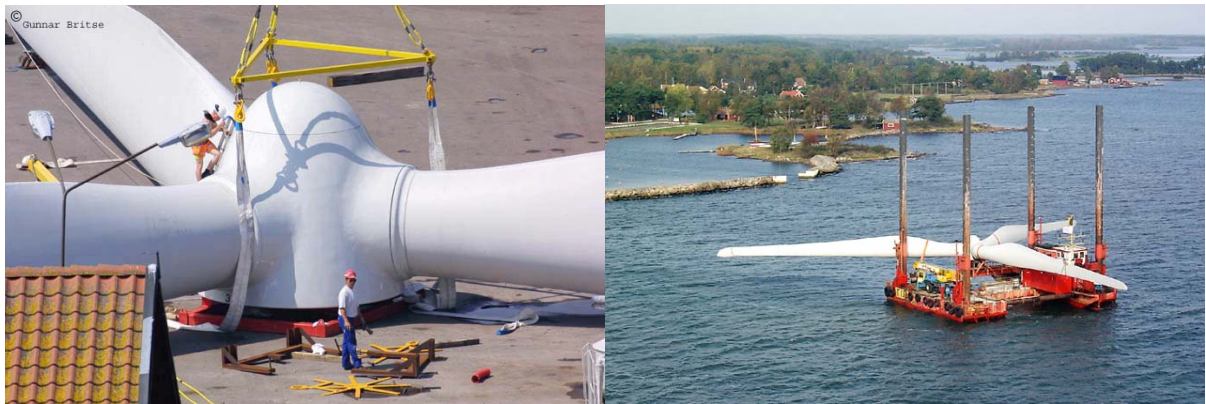
Figura 7. Etapas de montaje y transporte de las palas giratorias (izquierda); una idea del tamaño se observa comparándolo con los operarios. A la derecha aparece el barco plataforma que se encargará de montar la estructura en la torre soporte.
