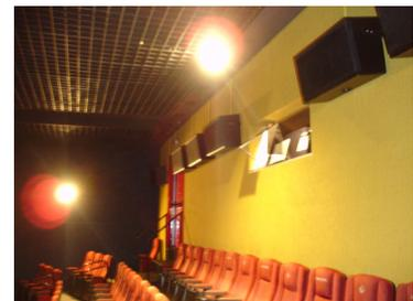
Figura 06: Grelha com lã de vidro no teto
