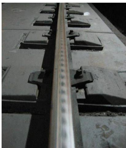
Figura 1.- El desgaste ondulatorio de onda corta es característico por la alternancia de manchas brillantes y oscuras
