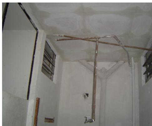
Figura 23: Duto de ventilação dos banheiros após fechamento
