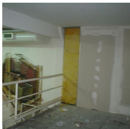
Figura 16: Detalhe do fechamento da parede
