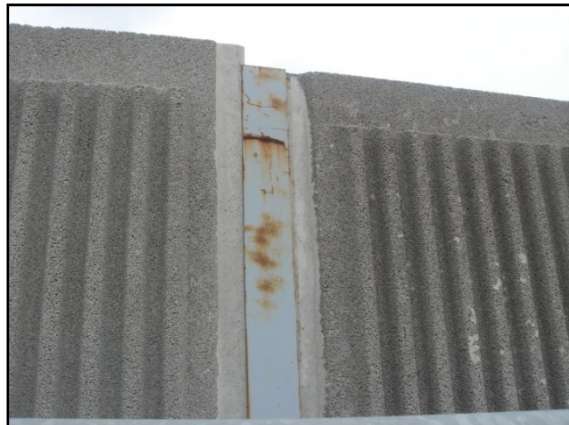
Figuras 2 y 3 – Principios de oxidación de un panel y de un perfil
