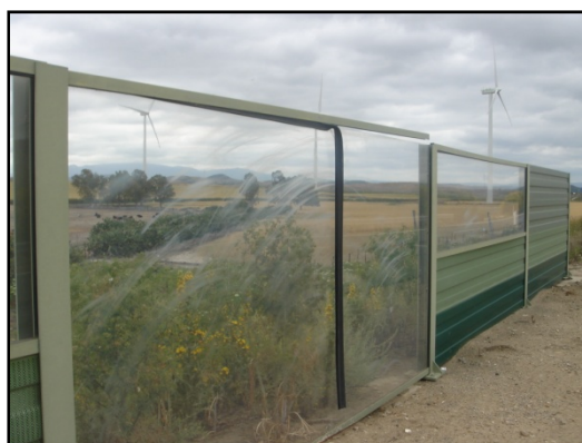
Figura 8 – Defecto en las soldaduras
