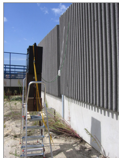
Figura 8 – Barreira em painéis pré-fabricados de betão
