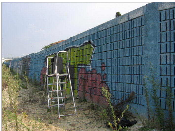
Figura 7 – Barreira em alvenaria
