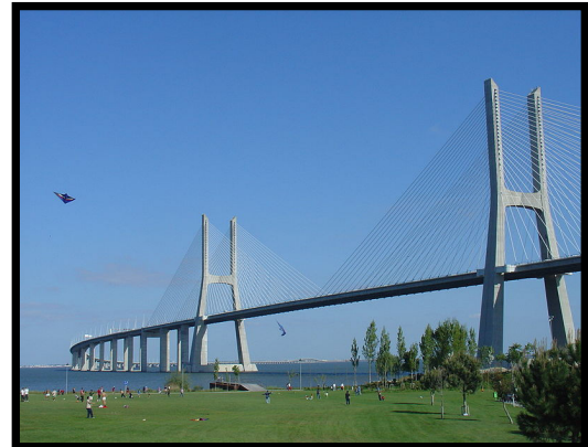
Ponte Vasco da Gama
