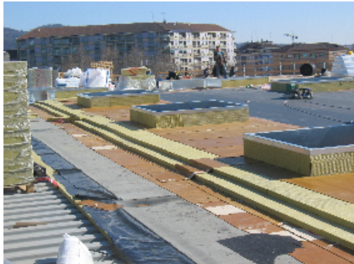
Fig. 12: Detalhe da cobertura
