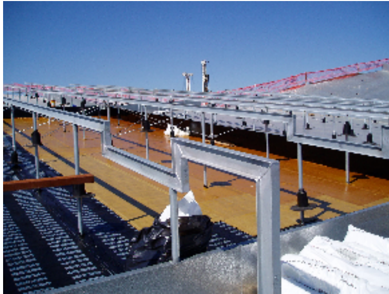
Fig. 14: Detalhe da cobertura
