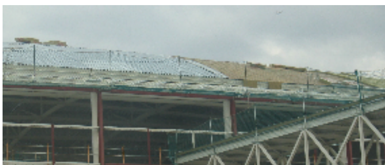
Fig. 10: Detalhe da cobertura
