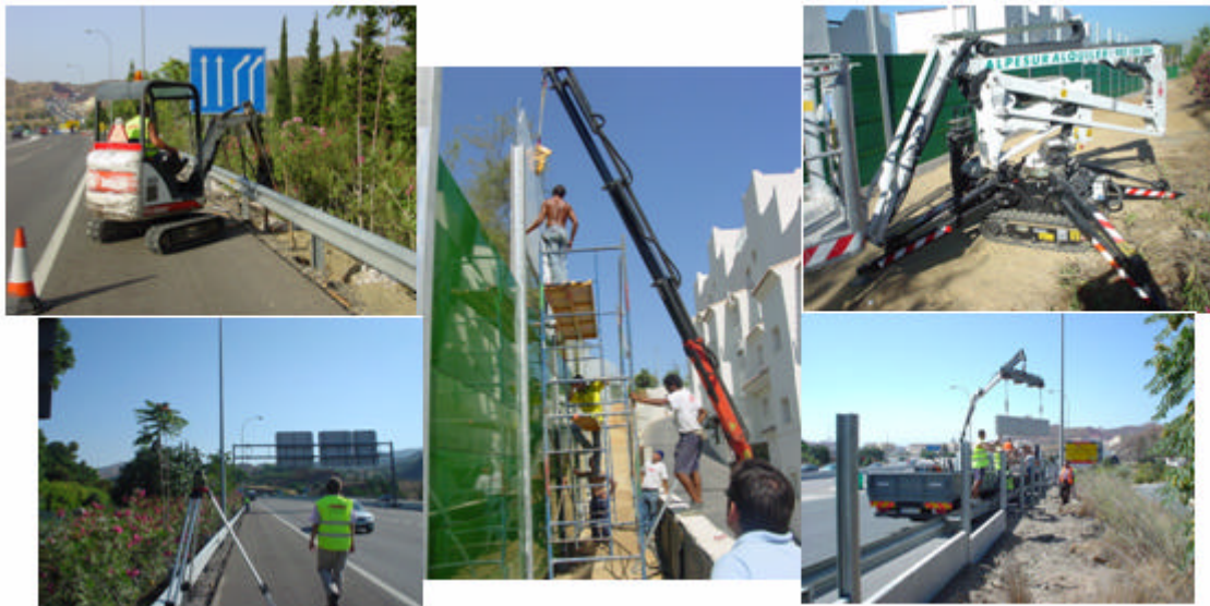
Figs.21-25 Maquinaria utilizada comúnmente para instalación de pantallas acústicas en carretera.
