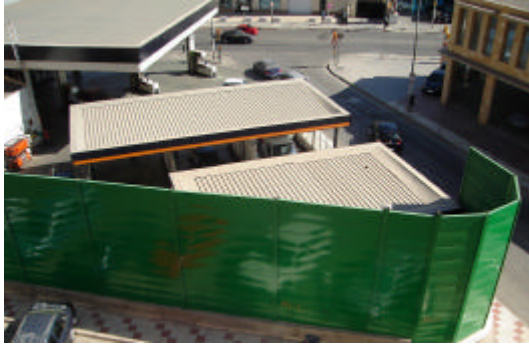
Fig.9 Vista de la gasolinera
