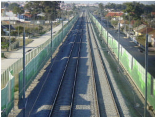
Fig.14 Pantallas metálicas absorbentes
