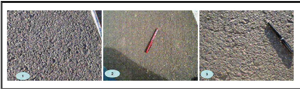
Fig. 2 Firmes sobre los que se han realizado los ensayo del ruido de rodadura.
