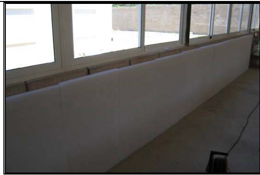
Figura 5: Parte trasera recubierta con fibra
