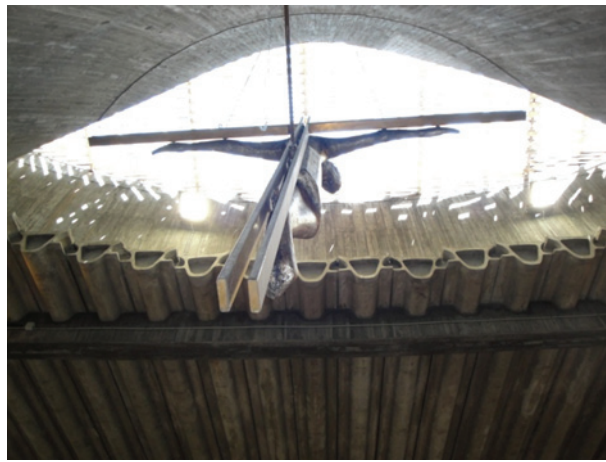
Figura 5. Lucernario y vigas hueso.
