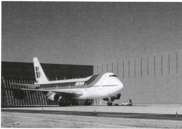
Figura 1.3. Ruido de aviones. Cabina acústica para ensayo de ruido de aviones (cortesía de Rheinhold & Mahla, S.A.).
