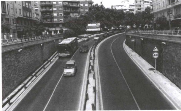
Figura 4.9. Imagen de un paso subterráneo en una de las grandes vías urbanas de la ciudad de Valencia.
