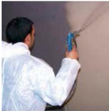
La membrana es impermeable al agua en estado líquido y permeable al vapor de agua, por lo que evita la introducción de agua a través del cerramiento dejando "respirar" a la fachada.
