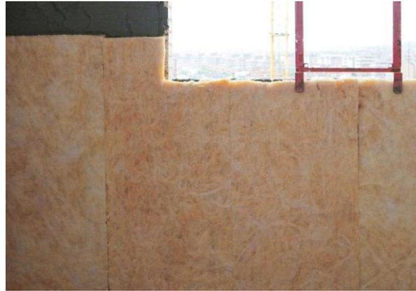
En el caso de que la lana mineral lleve una barrera de vapor para protección frente a condensaciones intersticiales, esta se sellará mediante una cinta adhesiva plástica.
