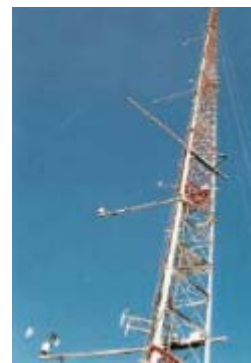
Fig. 3.- Detalle de la torre meteorológica
