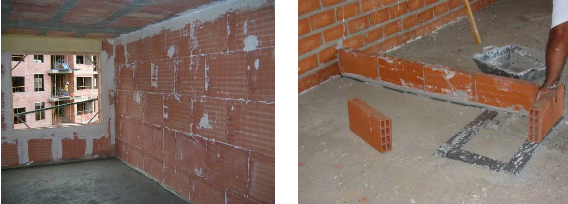
Figura 3: Ejemplo del sistema colocado con LGF (Promoción en Amurrio) y con formatos tradicionales (promoción en Mérida)
