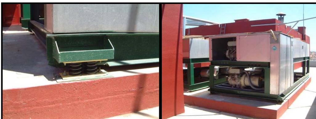
Figura 5 – Apoios instalados e vista de conjunto dos “chillers”.
