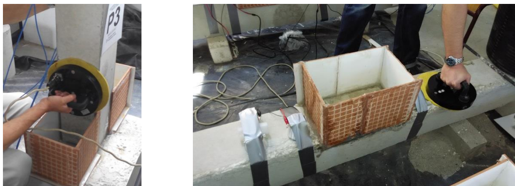
Figura 11: Detalle del proceso de medida de Ecor e Icorr en un pilar (izquierda) y en una viga (derecha).
