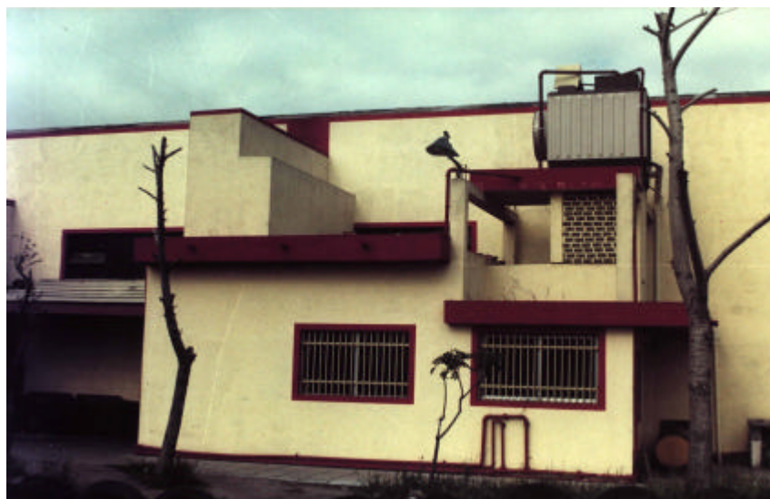
FOTO B: Vista de una instalación en empresa de transporte desde playa de estacionamiento hacia las oficinas.
