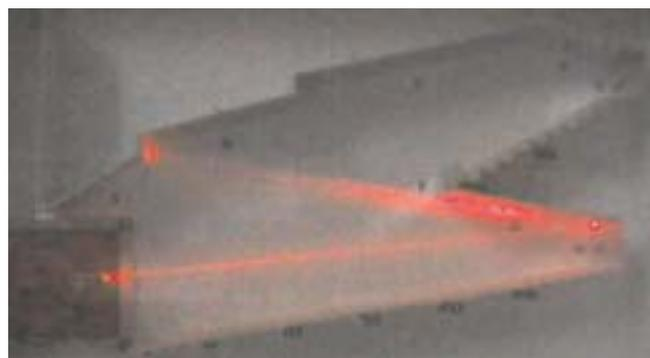
Figura 18. Eco. Pared posterior de la platea (H) al techo. Foto del autor.
