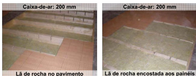
Figura 12. Aplicação de lã de rocha no interior da caixa-de-ar.
