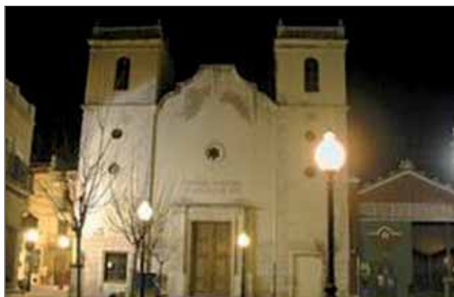
Figura 1: Fachada de “Sant Agustí”.
