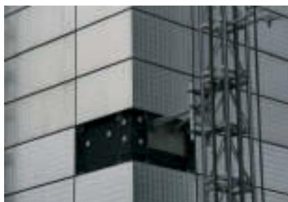
Las soluciones basadas en el principio de la fachada ventilada aportan múltiples ventajas desde el punto de vista del confort y el ahorro energético puesto que favorecen una corriente de convección que permite evacuar el calor que incide sobre ellas de manera natural.
