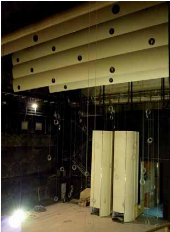
Cada módulo está basado en una estructura de perfilera metálica con rodamientos que permiten su transporte, montaje y almacenamiento.
