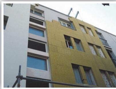
La instalación de sistemas SATE con lana de roca ISOFEX está especialmente indicada para rehabilitación de fachadas, donde proporciona importantes ventajas frente a los sistemas tradicionales de rehabilitación por el interior. Al realizar la obra por el exterior no es necesario desalojar el edificio, evitando incómodos traslados a las personas que habitan o trabajan en el mismo. Además al realizar la reforma por el exterior de la fachada, los metros cuadrados útiles del edificio no varían.
