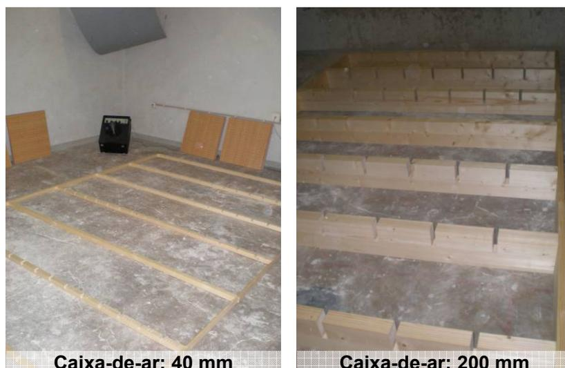
Figura 3. Estruturas de suporte dos painéis.
