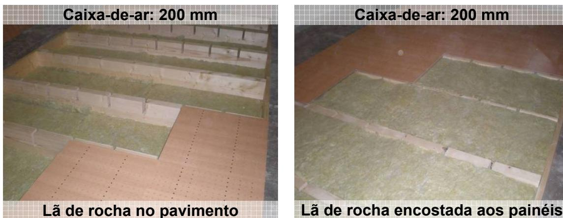
Figura 4. Aplicação de lã de rocha no interior da caixa-de-ar.
