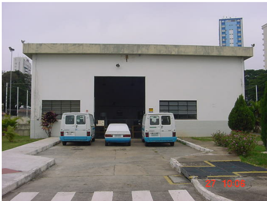
Figura 3. Sistema R3, vista externa – São José dos Campos
