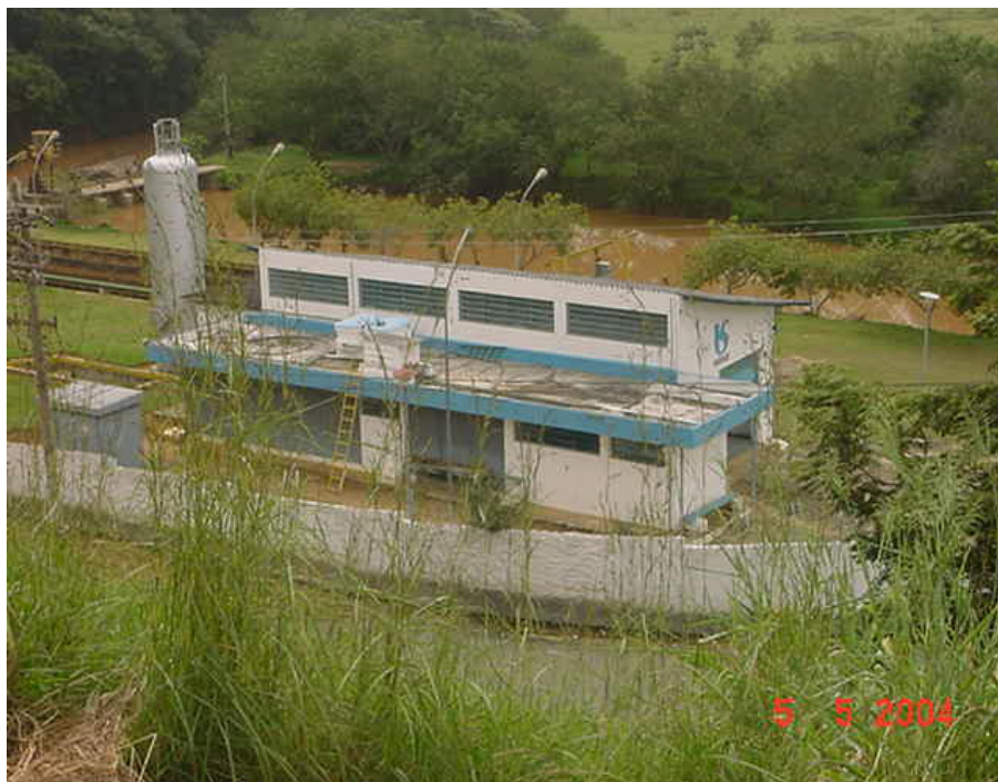
Figura 5. Captação Rio Una, vista externa – Taubaté
