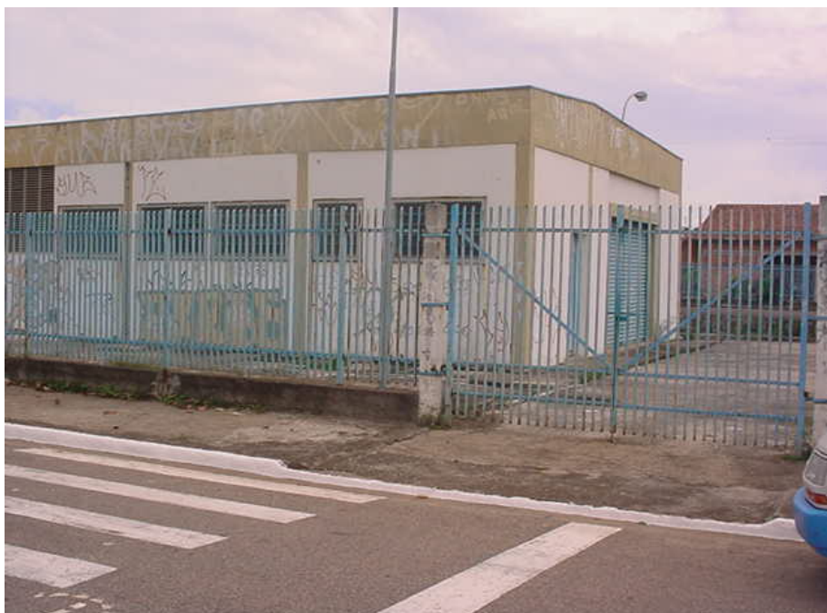
Figura 1. Estação Elevatória de Água tratada Indústria, vista externa – São José dos Campos
