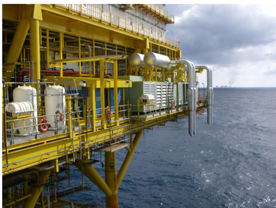
**Figura 2.** Vista de los dos generadores confinados, con los silenciadores de descarga de gases y los louvers de ventilación.
