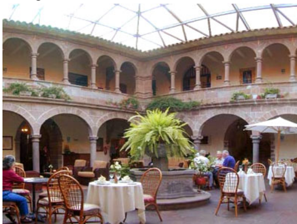
Figura 1. Fotografía del patio interno del Hotel.
