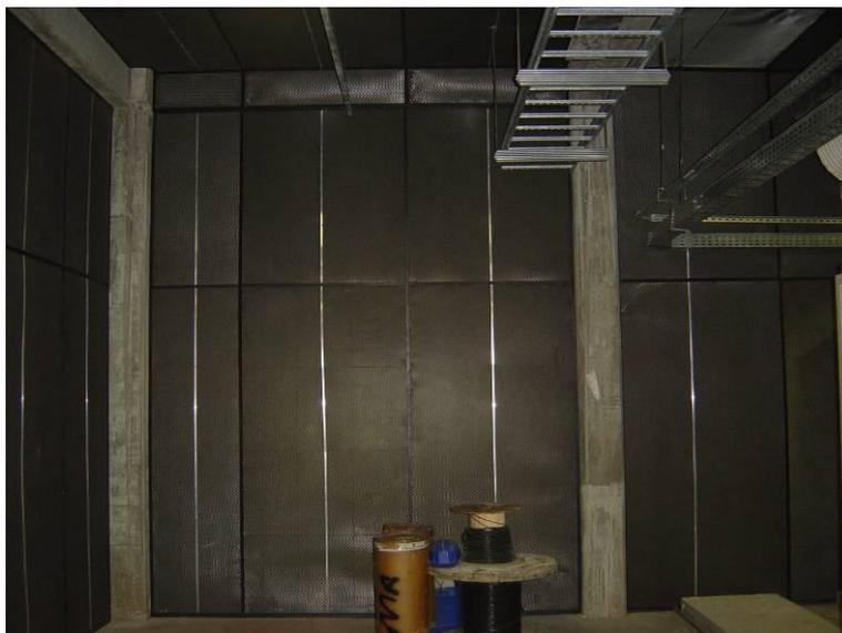
**Figura 2.** Foto do detalhe do isolamento das paredes divisórias entre a Sala da Central de Resfriamento de Líquidos e o exterior do edifício e salas contíguas
