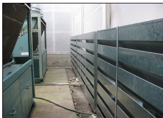
Figura 7 – Barreira acústica com grelhas acústicas incorporadas
