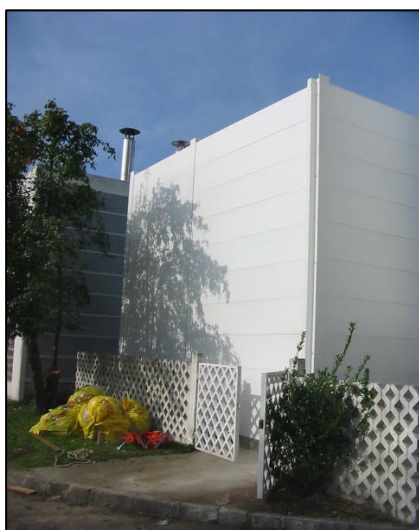
Figura 7 – Barreira acústica com grelhas acústicas incorporadas
