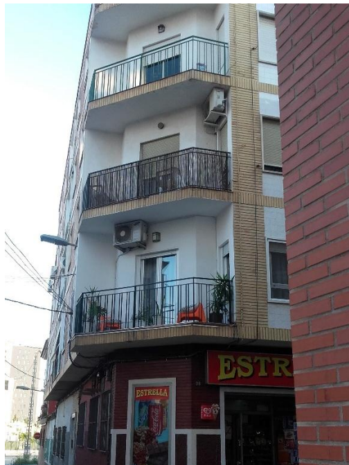
Figura 1. Vista de la fachada del edificio en el que se instaló el dispositivo.
