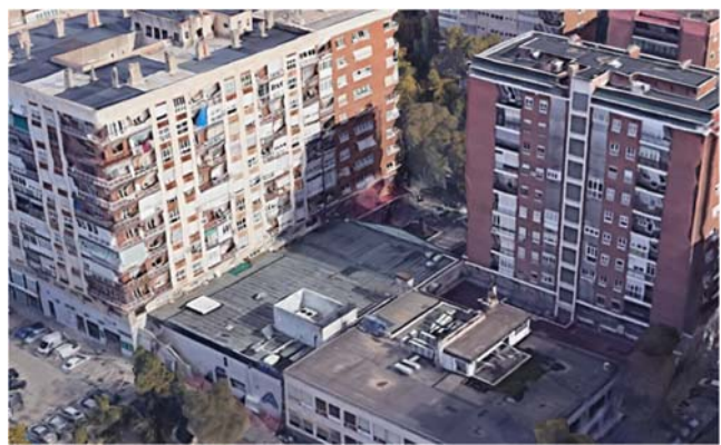
Figura 1. Vista de equipos en cubierta apantallados en presencia de edificaciones residenciales de mayor altura. (Fte: Google Earth)
