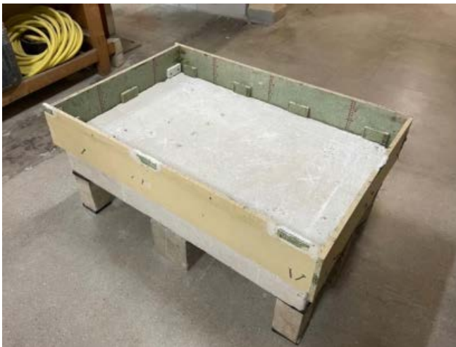
Figura 3. Encofrado para losa flotante.
