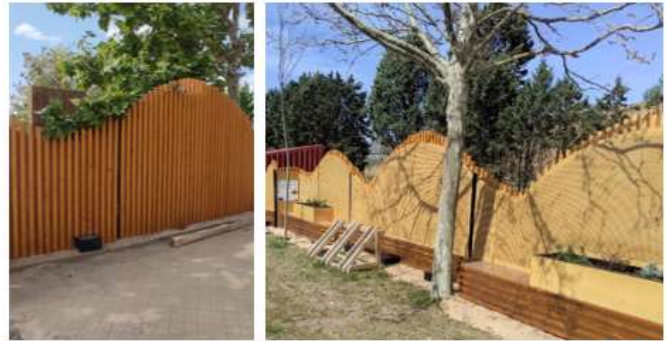
Figura 12. Barrera multifuncional instalada.
