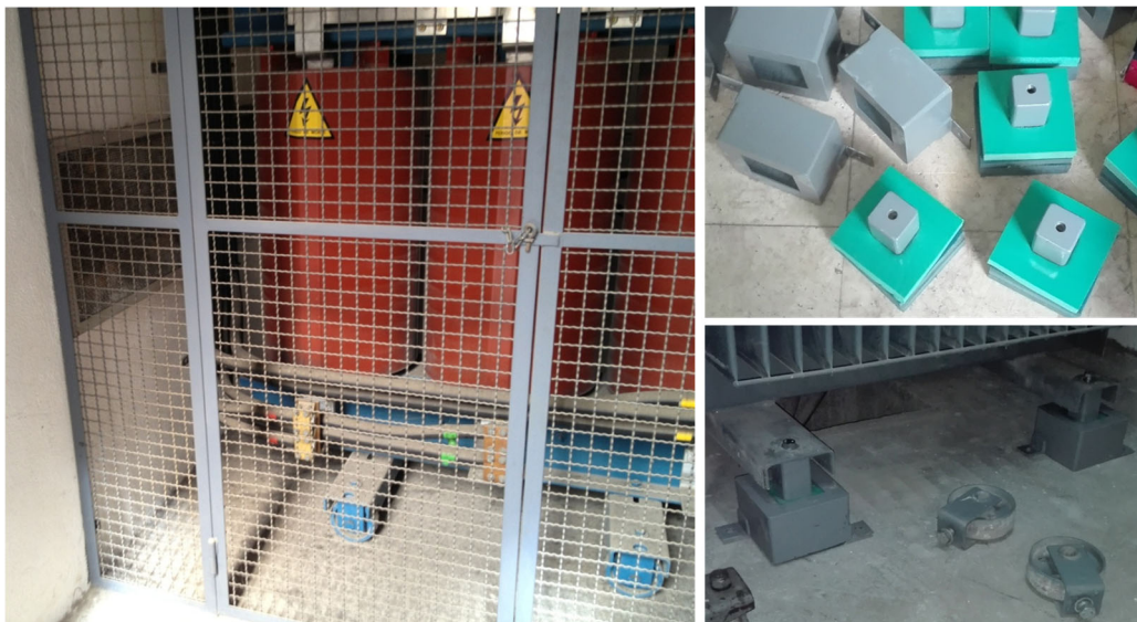
Figura 3: Possível solução de apoios antivibratórios (e antissísmicos), para substituição de um apoio convencional (geralmente com rodízio), em instalações de PT já existentes.
