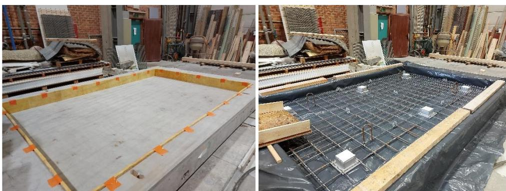
Figura 1 – Instalación del aislamiento perimetral y cajas Stravifloor Jackup-R ya instaladas, con mallazo de refuerzo.
