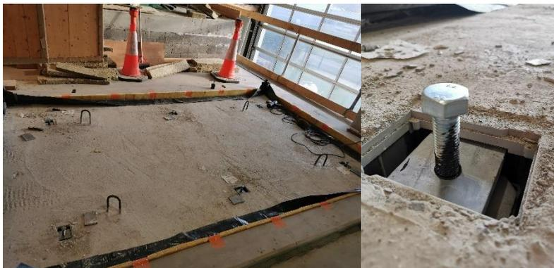
Figura 9 – Losa flotante de hormigón tras curado, con los gatos destapados, listos para proceder con el levantamiento.
